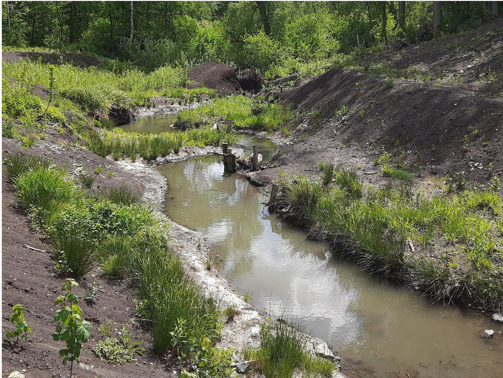
Abbildung 2: neu geschaffenes Doppeltrapezprofil mit Niedrigwasserrinne und Strukturelementen (Mai 2025) -Aufnahme HGN
