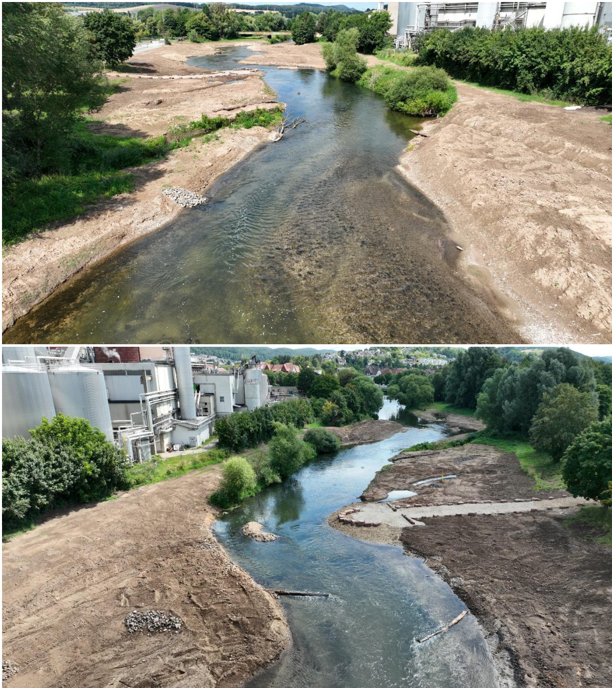
Bild 1 : Ausschnitt Luftbilder Bermenabgrabung Bauabschnitt 1
